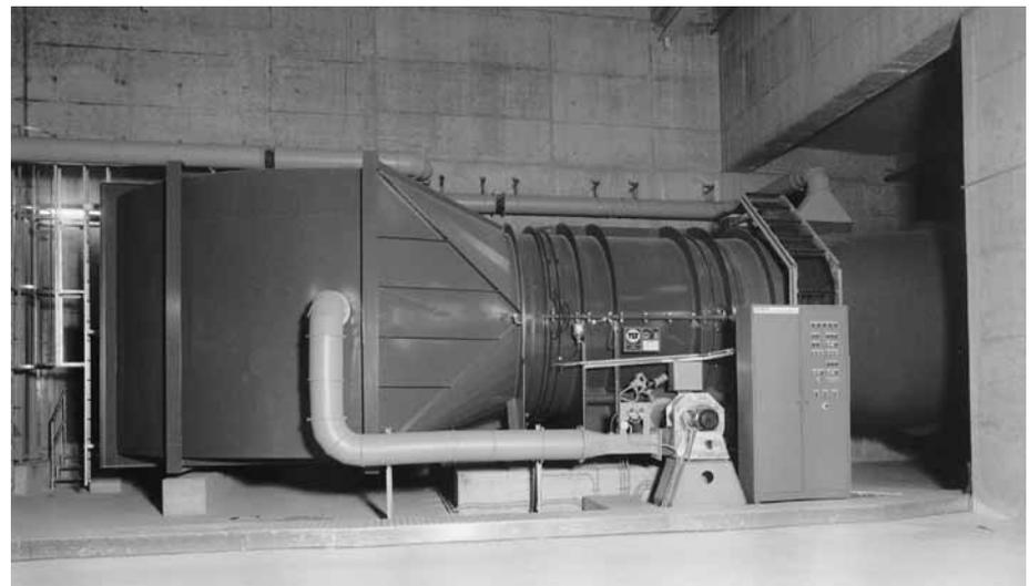
Fig. 4: Axial-flow exhaust fan
